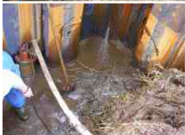
Nachbergung innerhalb des Spundwandkastens
