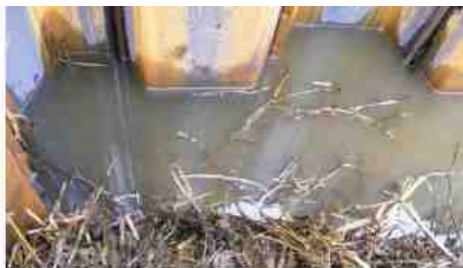
Nachbergung innerhalb des Spundwandkastens
